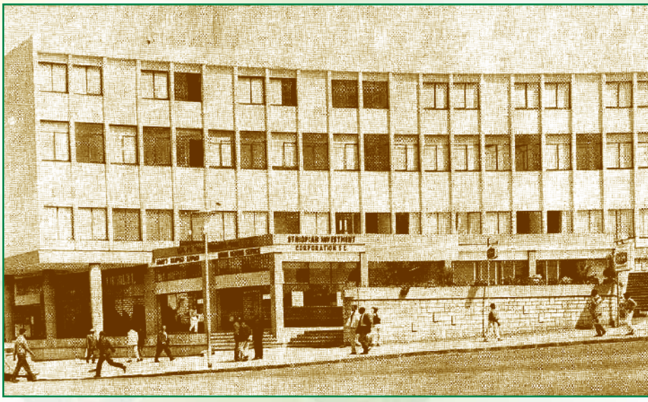
የአገር ሥራ ማስፋፊያ ባለአክሲዮን ማኅበር ዋና መ/ቤት / የአሁኑ የአራት ኪሎ ፖስታ ቤት/
